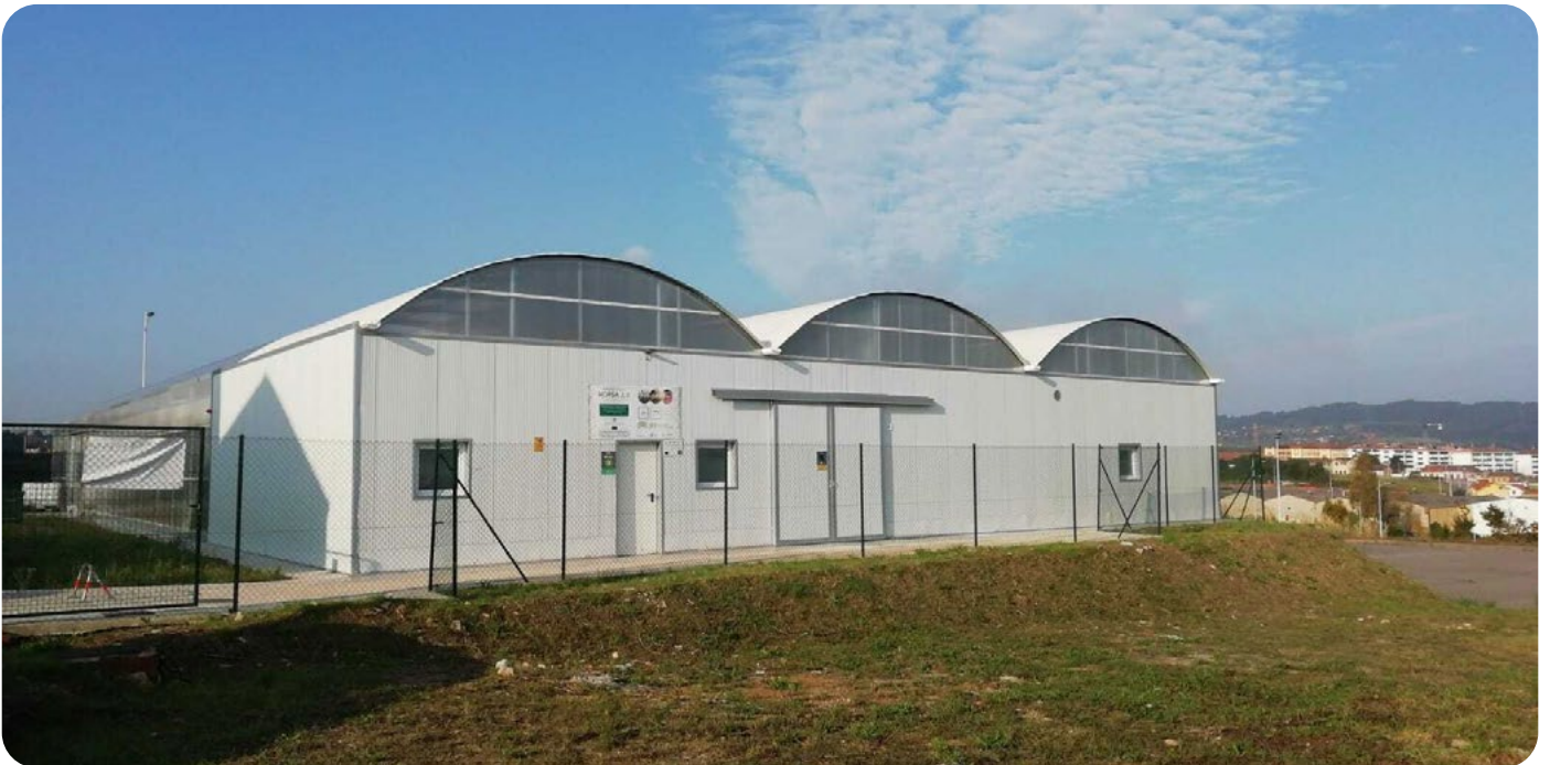
Exteriores de la planta de NEOALGAE
